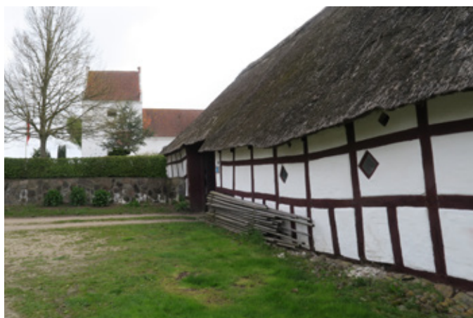
Skydebjerg Kirke med den nærliggende fredede præstegård i sulekonstruktion
